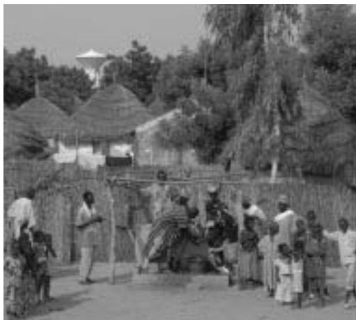
給水塔(後方)と水道のおかげで、村人たちは容易に安全な水にアクセスできるようになった。施設の管理も水管理組合が行っている。セネガル・ルーガ近郊にて(撮影:今村健志朗)
